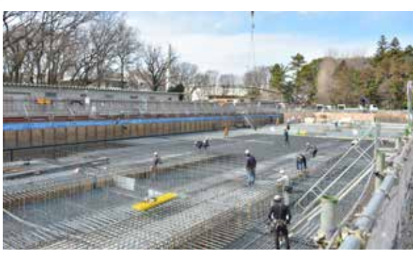
医学部講義棟イメージ (上)。現在、建物の基礎工事が進んでいる。鉄筋の組み立て完了後、順次コンクリートの打設が施工されていく (2/19撮影)
